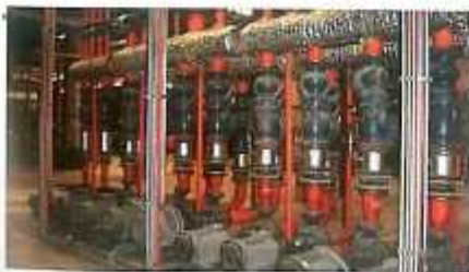
لرزه گیرهای لاستیکی فلکسور نصب شده در تأسیسات مرکزی کنیخته ملی ایران
