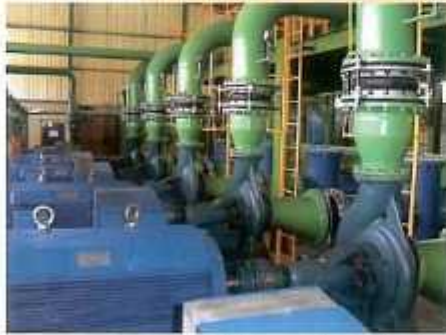
لرزه گیر لاستیکی فلکسور سایز: ۱۶ اینچ نوع مهاردار پروژه: پمپخانه کارخانه شیشه سازی
