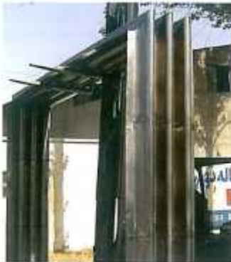
اتصال انبساطی فلزی ۲۲۰۰x۲۷۰۰ میلیمتر
